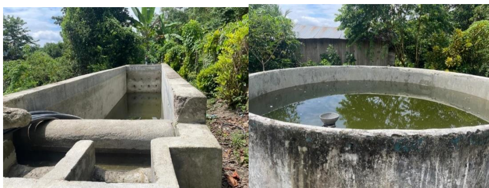
Ilustración 16. Sistema de captación y distribución de agua en la cabecera parroquial Cube
